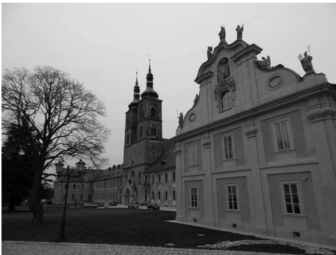
Obr. 2: Klášterní nádvoří. Prosinec 2015 (foto autor).
